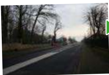
RÉFECTION DE LA VOIRIE ENTRÉE DE VILLE côté Tournan jusqu'au droit de la résidence Champagne
