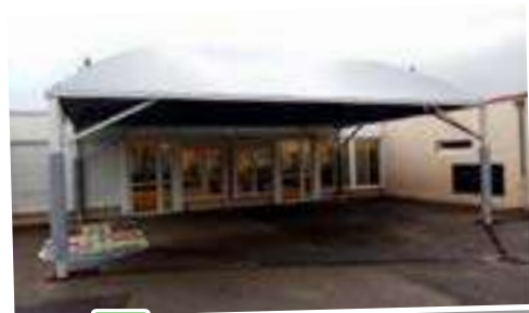
MISE EN PLACE D'UN PRÉAU dans la pour la maternelle de l'école Victor Hugo
