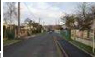
TRAVAUX DE VOIRIE août 2020 - Rue des bruyères et Avenue des glands
