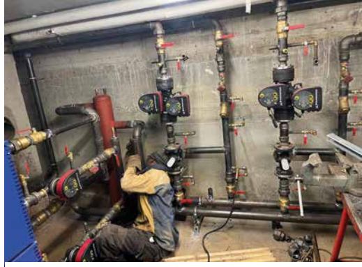
Avancement des changements de chaufferie dans les écoles maternelles Victor Hugo et Leclerc, Maison de la culture et loisirs et de la Mairie.
