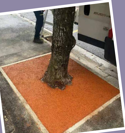
Pied d'arbre boulevard Victor Hugo : Certains pieds d'arbres ont été rénovés avec du PERMEO, (revêtement drainant stabilisé et perméable).
