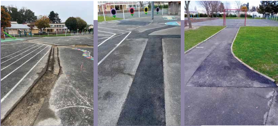
Travaux de reprise des fissures sur les cours de récréation de l'école Victor Hugo
