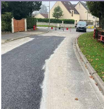
Travaux Place Victor Hugo, remise en état d'une partie de la bande de roulement.
