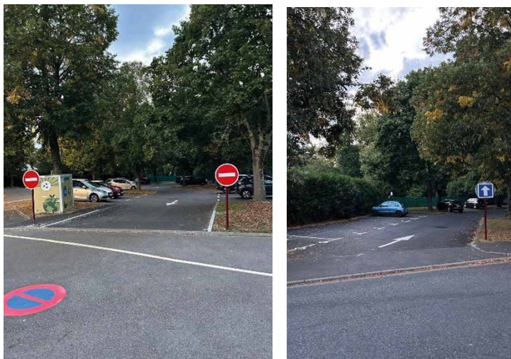
Réfection du parking du collège et du gymnase HUTINEL
