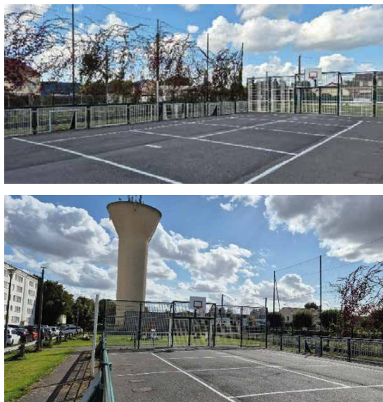
Rénovation du city parc / rue Gambetta.
